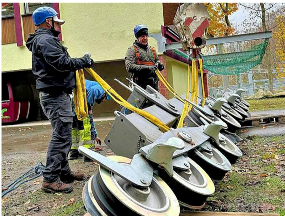
Sie wird nun komplett auseinandergenommen. Einzelteile werden mit der magnetinduktiven Methode überprüft, Verschleißteile ersetzt. Ausgestattet mit neuen Bolzen und neu gefettet wird die Einheit zusammengesetzt und wieder oben montiert. Dabei muss darauf geachtet werden, dass das Förderseil korrekt unter den Rollen entlangführt. Bei den anderen vier Stützen – eine ist 50 Meter hoch – führt das Seil hingegen über die Rollen.
